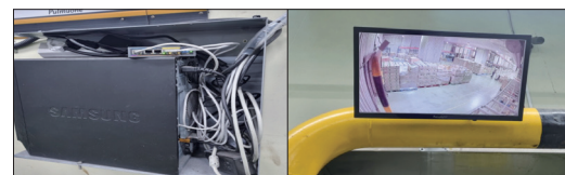
7 방열문 내외 작업자 확인용 CCTV 설치 시야 확보를 통한 충돌 방지
