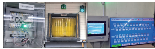
1 상하차 모니터링 시스템 차량 출발로 인한 작업자 추락 방지
