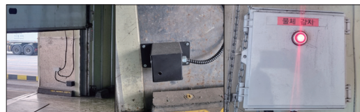
6 도크 도어 안전 센서 설치 도크 도어 하강 시 작업자 끼임 방지
